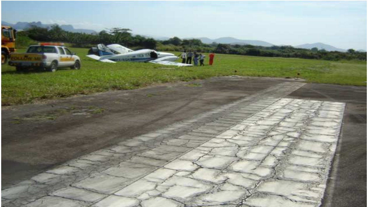
Foto 1: Trajetória de saída da pista, pilones de iluminação de fim de pista, tampa da caixa de passagem e área de escape desobstruída.
