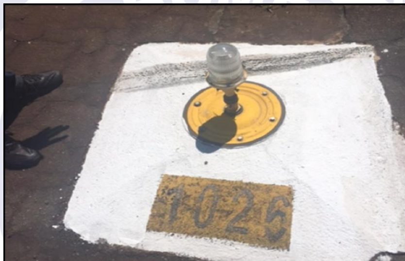
Figura 2 - Estrutura de concreto localizada à lateral da pista.
