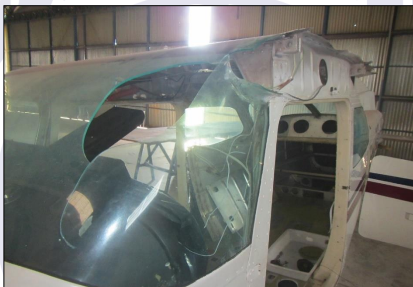
Figura 4 - Danos à aeronave.
