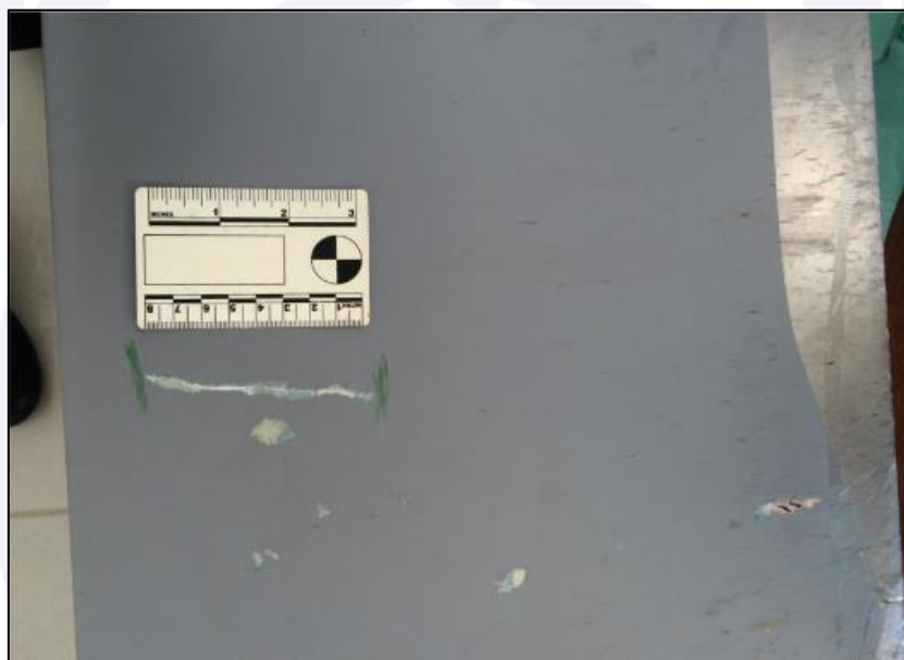
Figura 3 - Dimensão de rachaduras no intradorso da pá.
