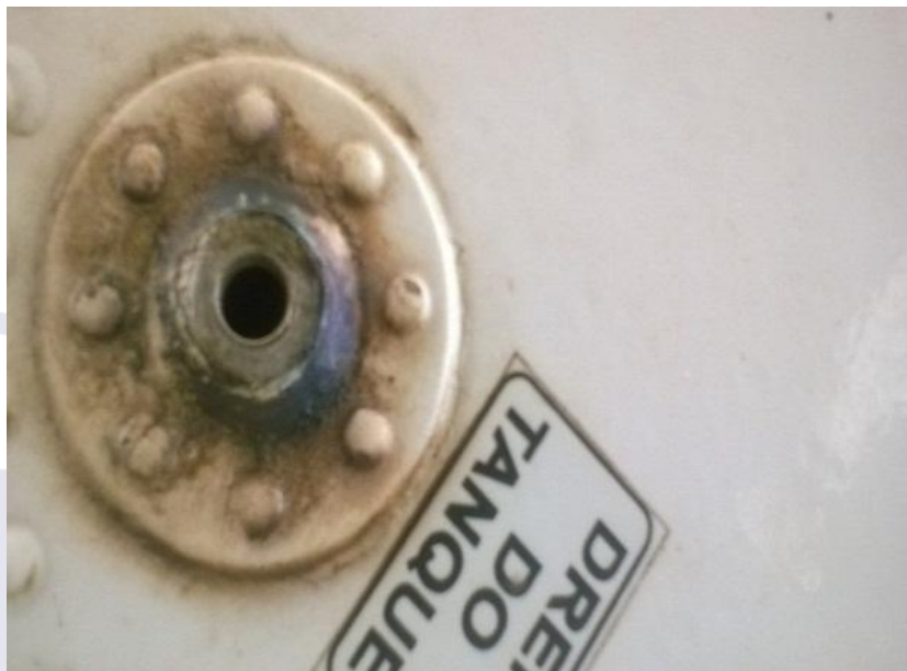
Figura 4 - Vista evidenciando a ausência do dreno do tanque interno da asa direita.
